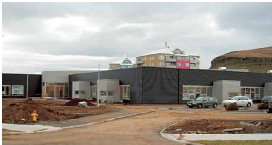
Verið er að leggja síðustu hönd á Korpuskóla í Grafarvogi. Fróðlegt verður að sjá hvort skólinn standist þær kröfur sem gerðar eru til grunnskóla, sem og annarra opinberra bygginga, um gott aðgengi. Mynd/kmh.
